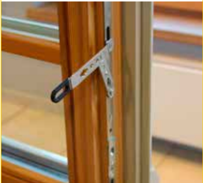
Crémone semi-fixe sur le deuxième ouvrant
